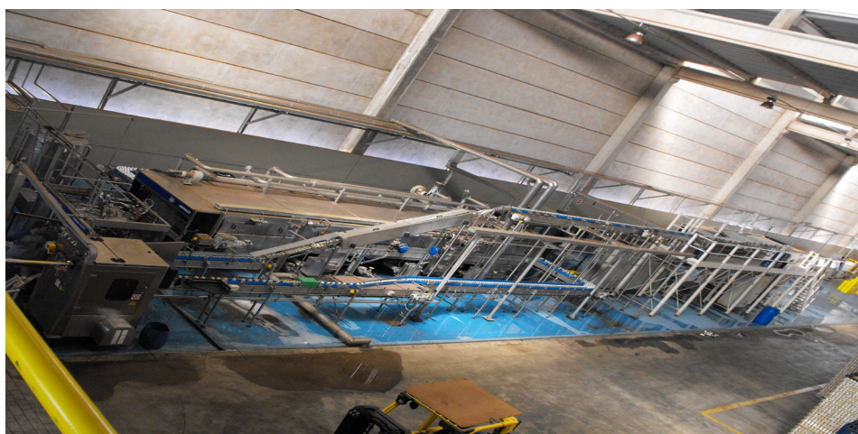
Figura 9 - Localização do equipamento que utiliza a radiação-x
